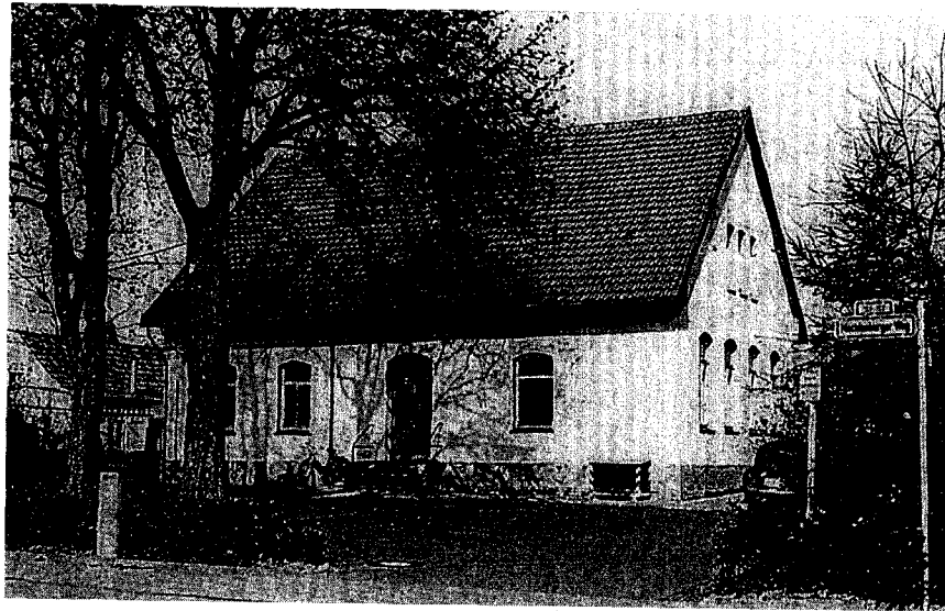
Gebäude der ersten Schule am Mecklenburger Weg, heute ein Kindergarten. Außer dem Klassenraum waren auch die Wohnungen der Lehrer in dem Haus untergebracht. Die Anschrift von Husmann und Flickenschildt im Jahre 1904 lautete: Leher Heide 31, Schule. Foto: Gabcke.
